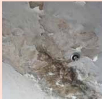
Ciams Novo Horizonte: infiltrações e mofo no teto do sanitário dos usuários
