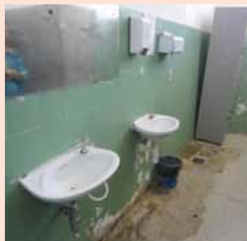
Cais Amendoeiras: banheiro com piso danificado e paredes descascadas
