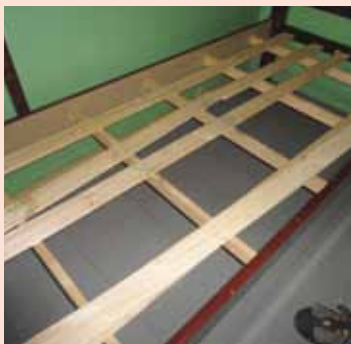
Cais Cândida de Moraes: quarto de repouso com cama quebrada
