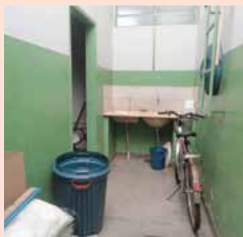
Cais Jardim Curitiba: objetos estranhos na entrada da lavanderia
